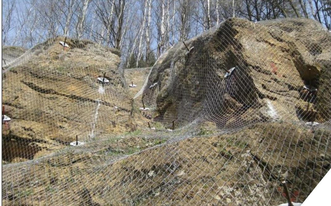
Laddove non sia possibile gli ancoraggi devono essere realizzati in concavità naturali per poi porre in tensione la rete per effetto del serraggio del dado dell'ancoraggio.
