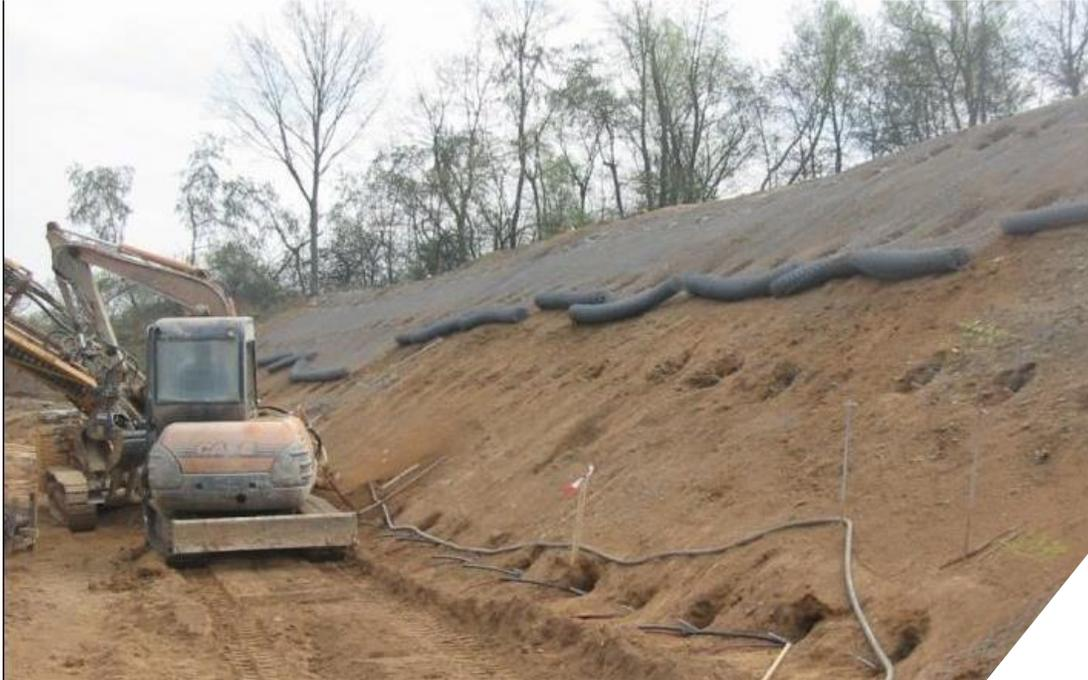
E'importante che laddove possibile (trincee) gli ancoraggi vengano realizzati in nicchie ricavate allo scopo, al fine di porre in tensione la rete nell'adiacenza dell'ancoraggio.
